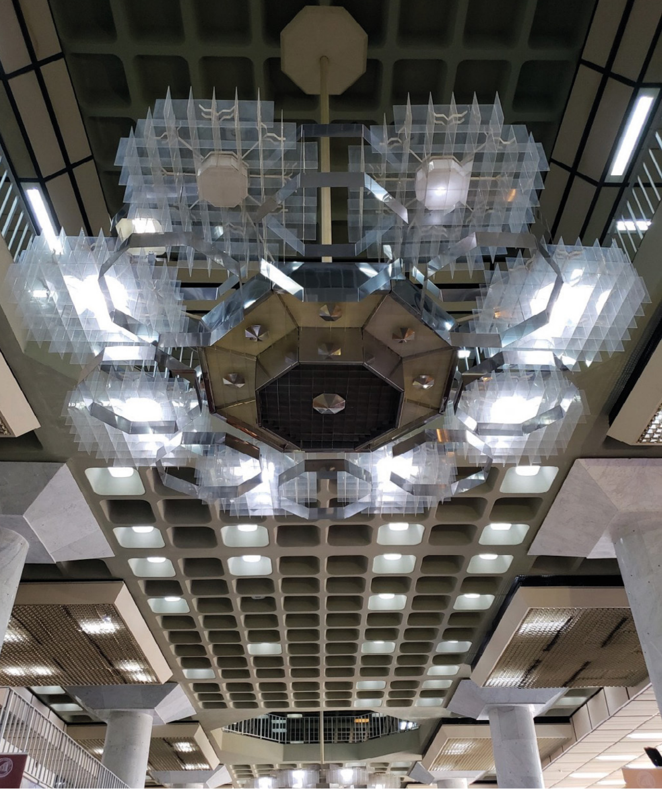
Arañas lumínicas en la Sala de Operaciones. Autor: Hermann Guggiari.
