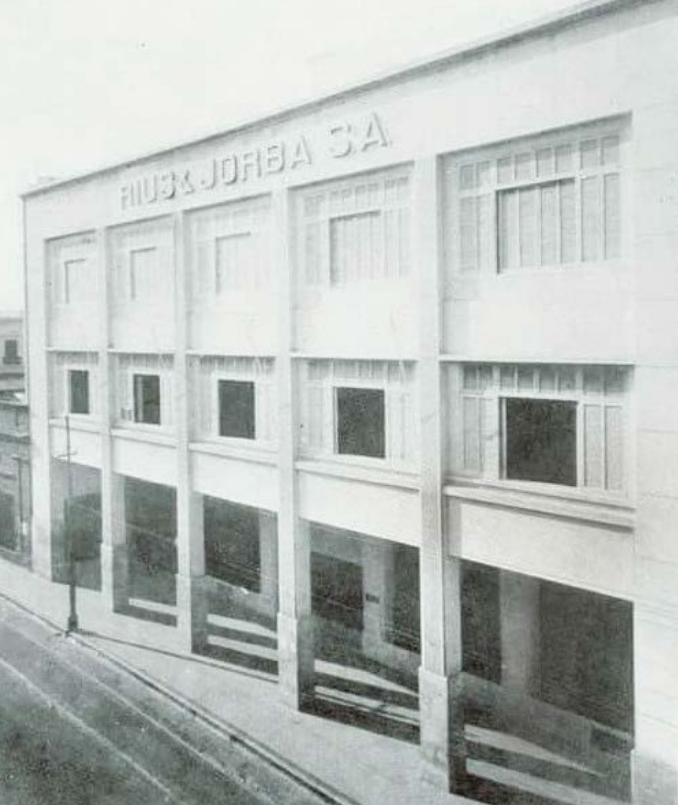
Edificio Rius & Jorba sobre la calle Palma entre 14 de Mayo y Alberdi donde funcionaron ciertas dependencias del Banco Central del Paraguay. El edificio hoy alberga a la Secretaría Nacional de Turismo (SENATUR).
