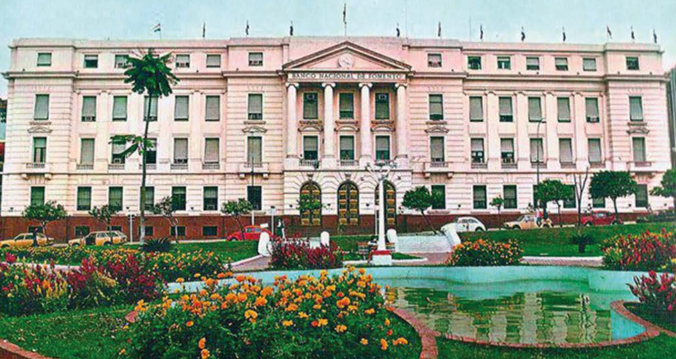
Edificio del actual Banco Nacional de Fomento que albergó parte de las oficinas del BCP desde 1952 hasta la inauguración y mudanza definitiva a la sede del complejo edilicio BCP.
