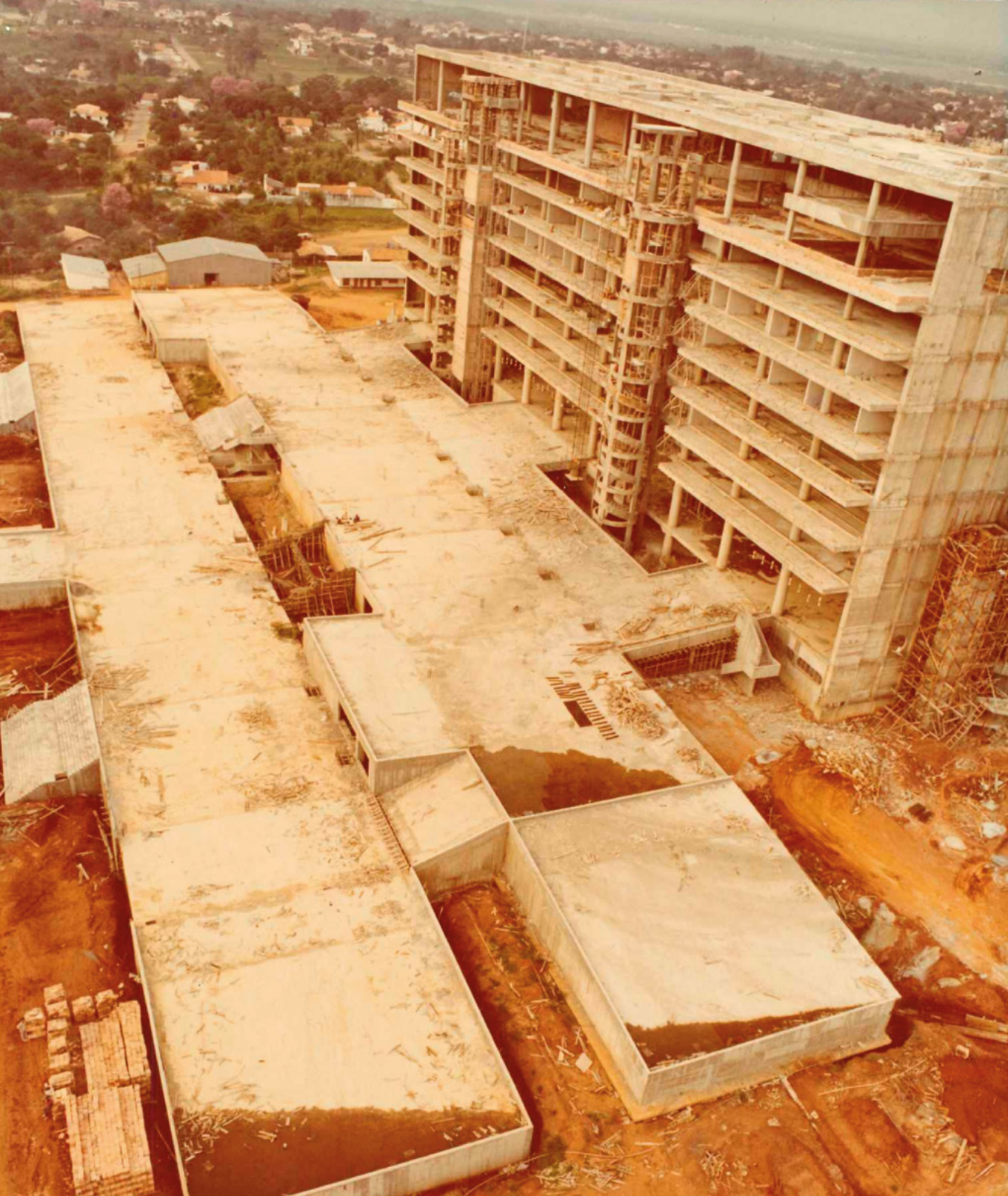
Construcción del edificio Banco, en proceso.
