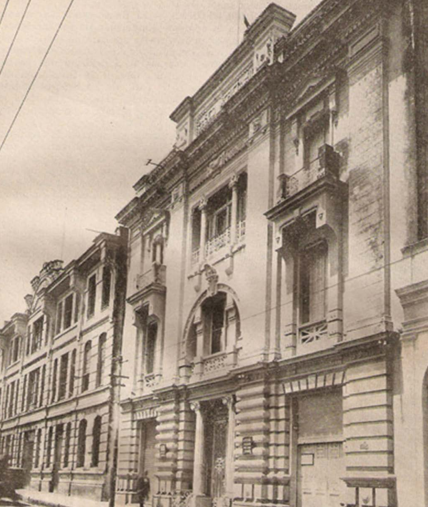
Edificio ubicado en la calle Presidente Franco c/ 14 de Mayo donde funcionó la Oficina de Cambios creada por ley 182 de 1916, institución embrionaria del Banco Central del Paraguay. El edificio hoy alberga oficinas del Ministerio de Agricultura y Ganadería.
